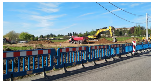
Début des travaux à Saint-Genis-Laval, été 2018
